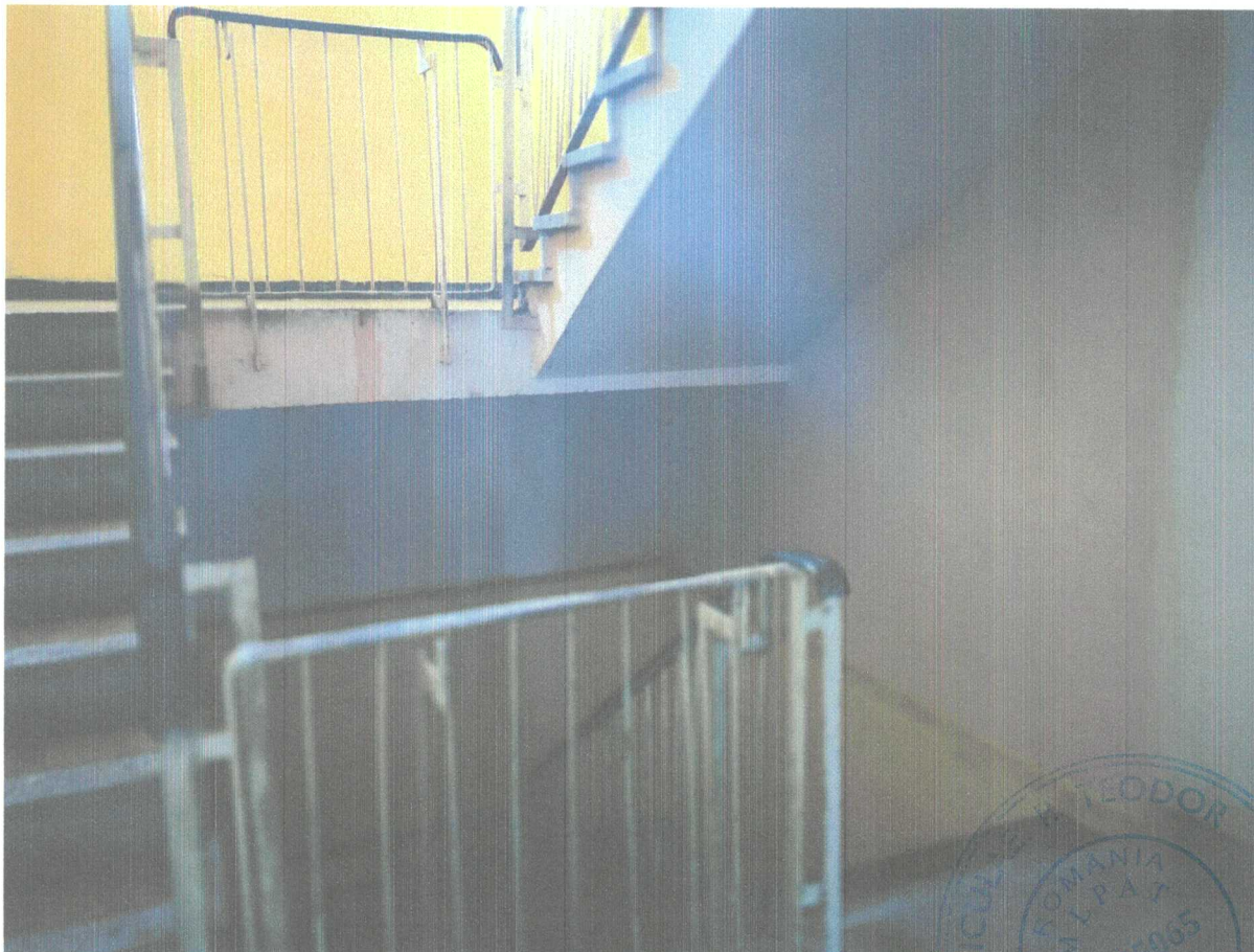
Casa scarii parter. Structura de rezistenta nu prezinta degradari. Finisaje inechite
