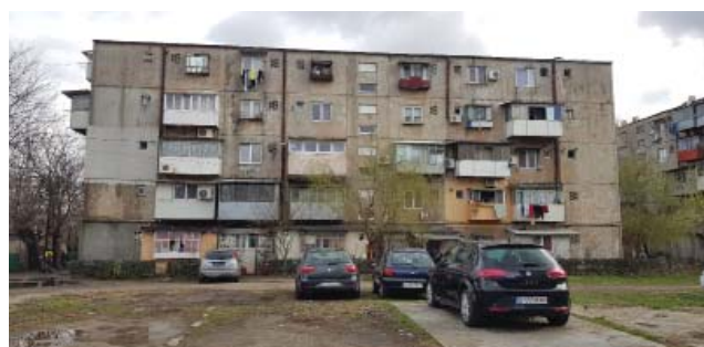
Blocuri pe str. Radu Constantin. Deșeuri aruncate între blocuri, sistem de canalizare deteriorat, fațade degradate. Unele blocuri au beneficiat de lucrări de renovare a fațadelor (vezi dreapta). Pe fațadele blocului locatarii au construit extensii suspendate în consolă pentru a spori spațiul de locuit al apartamentelor lor, un indicator comun al condițiilor de locuire supraaglomerate.
