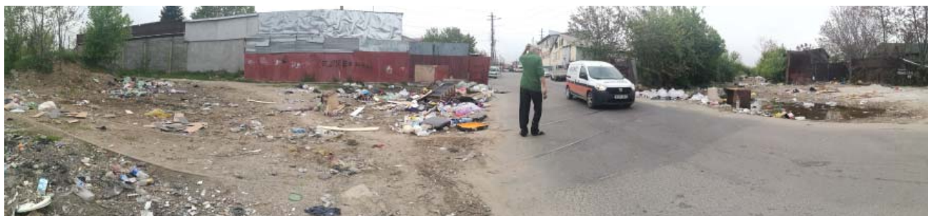
Traversarea coridorului feroviar pe Str. Zăbrăuțului către piața și parcul Ferentari: grămezi de gunoi, lipsa trotuarelor și a iluminatului stradal, drumuri înguste. Sursă: Material realizat de echipa Băncii Mondiale pentru acest angajament.
