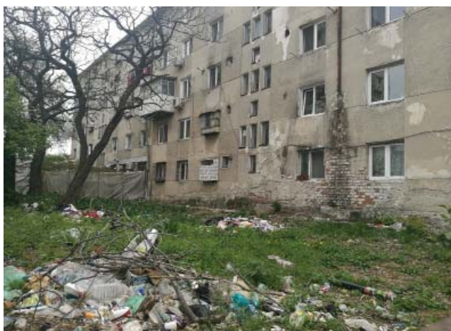
Blocuri pe str. Radu Constantin. Deșeuri aruncate între blocuri, sistem de canalizare deteriorat, fațade degradate. Unele blocuri au beneficiat de lucrări de renovare a fațadelor (vezi dreapta). Pe fațadele blocului locatarii au construit extensii suspendate în consolă pentru a spori spațiul de locuit al apartamentelor lor, un indicator comun al condițiilor de locuire supraaglomerate.
