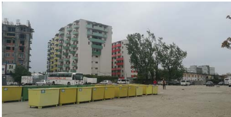
Fostul teren Flora/D.S. Raftopol, folosit ca parcare și piață săptămânală de vechituri. Pe fundal, dezvoltarea ISG Residence în curs (vedere din Str. Dr. C. Istrati)
