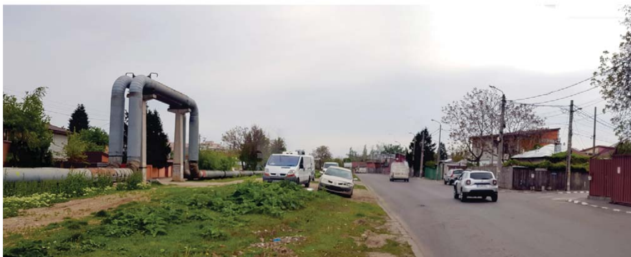
Fotografie: Str. Brăniștari, de-a lungul conductelor de termoficare (înainte)
