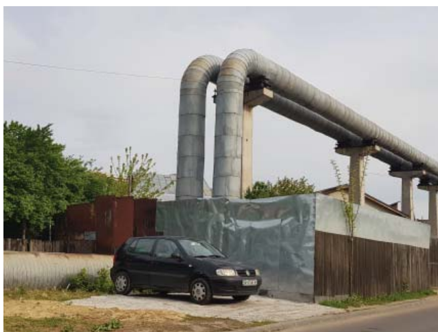
Coridor feroviar de-a lungul str. Brăniștari, zone împrejmuite și barăci de uz privat
