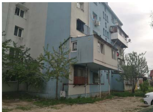
Blocuri pe str. Radu Constantin. Deșeuri aruncate între blocuri, sistem de canalizare deteriorat, fațade degradate. Unele blocuri au beneficiat de lucrări de renovare a fațadelor (vezi dreapta). Pe fațadele blocului locatarii au construit extensii suspendate în consolă pentru a spori spațiul de locuit al apartamentelor lor, un indicator comun al condițiilor de locuire supraaglomerate.
